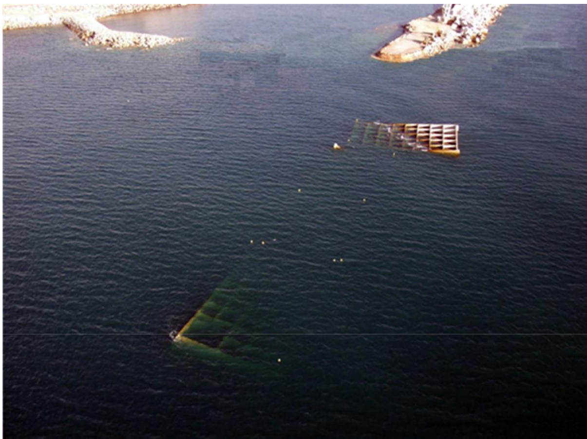
Rys. 1.3. Zniszczony falochron kesonowy w porcie Barcelona (fot. za (Puzrin, et al., 2010)).
