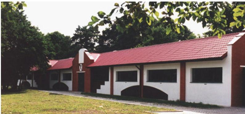
Fig. 5. Budynek kanału falowego (fot. Archiwum)
