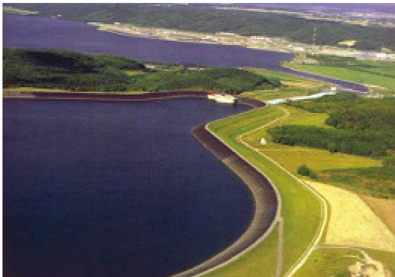
Fig. 17. Górny zbiornik elektrowni szczytowo-pompowej Żarnowiec. U góry fragment Jeziora Żarnowieckiego oraz plac budowy elektrowni jądrowej. Na przesmyku istniejąca elektrownia, w budowie której IBW miał duży udział
